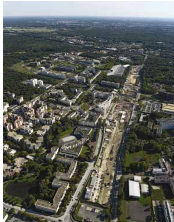
Les Hauts de Nesles / Cité Descartes à Champs-sur-Marne à la lisière de Noisy-le-Grand : chantier de la SGP le long du boulevard du Ru de Nesle.
