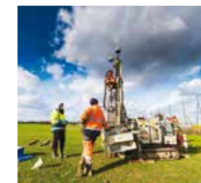
Villiers-sur-Marne ZAC Marne-Europe Aménagement de la future gare du Grand Paris Express de Bry - Villiers - Champigny Forage sur le site de Villiers-sur-Marne
