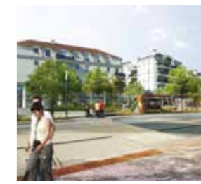
Bussy saint-Georges ZAC du Centre ville Réaménagement du pôle gare Mo : Epamarne MoE : Groupe 6
