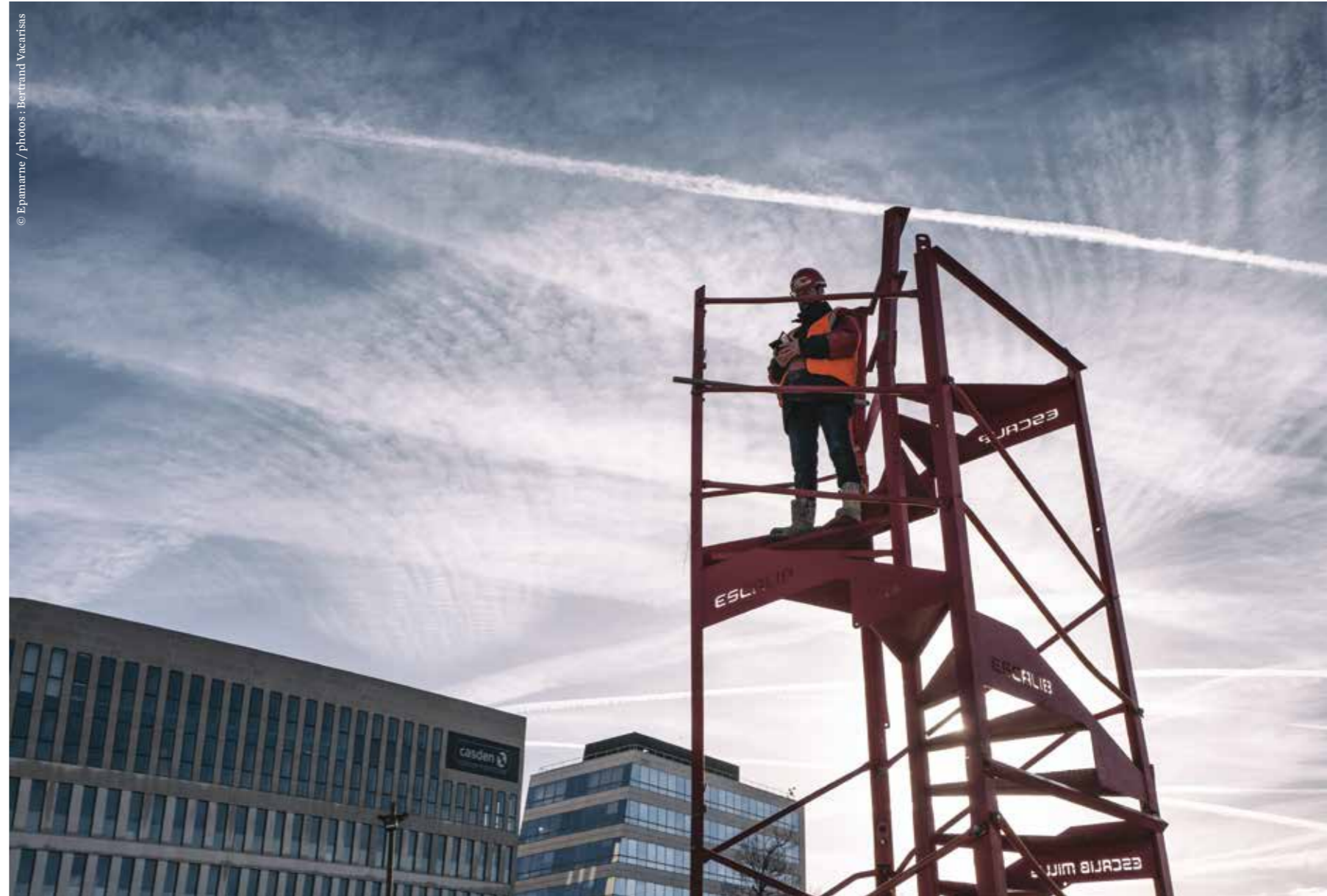
Chantier de la gare Noisy-Champs de la ligne 15 sud du Grand Paris Express.
