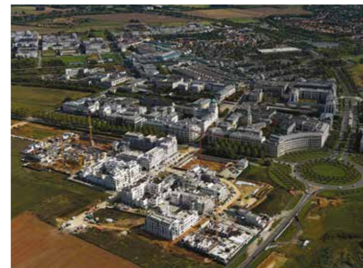
Serris & Chessy : Centre urbain du Val d'Europe / ZAC des Studios et des Congrès : Les chantiers du quartier nouveau des Studios situé dans le prolongement de la rue d'Ariane (Quartier de la Gare).
