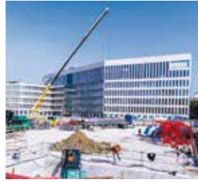
Champs-sur-Marne ZAC de la Haute Maison Siège social CASDEN Banque Populaire Mo : Les Nouveaux Constructeurs MoE : Colboc Franzen et associés
